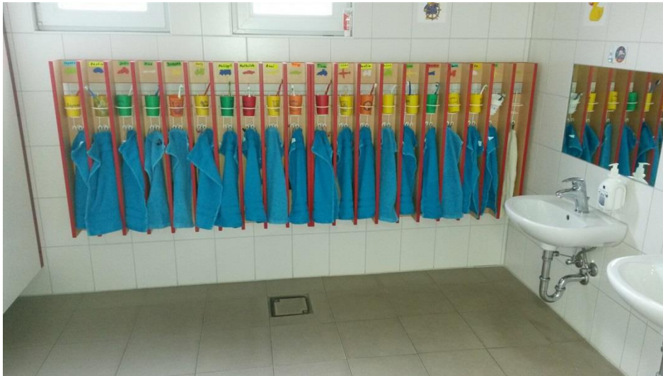
Beispiel 1: Waschraumleiste vom Kita-Ausstatter mit Trennwänden
