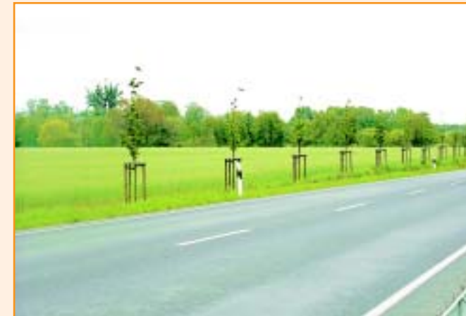
Eingriffsregelung am Beispiel eines Bebauungsplans: Für den Neubau der Straße "Anbindung B96neu an L172" zwischen Oranienburg und Leegebruch wurden zur Minderung der Beeinträchtigungen bzw. für die Kompensation des Eingriffes u.a. ein Krötentunnel errichtet und eine Baumreihe angelegt.
